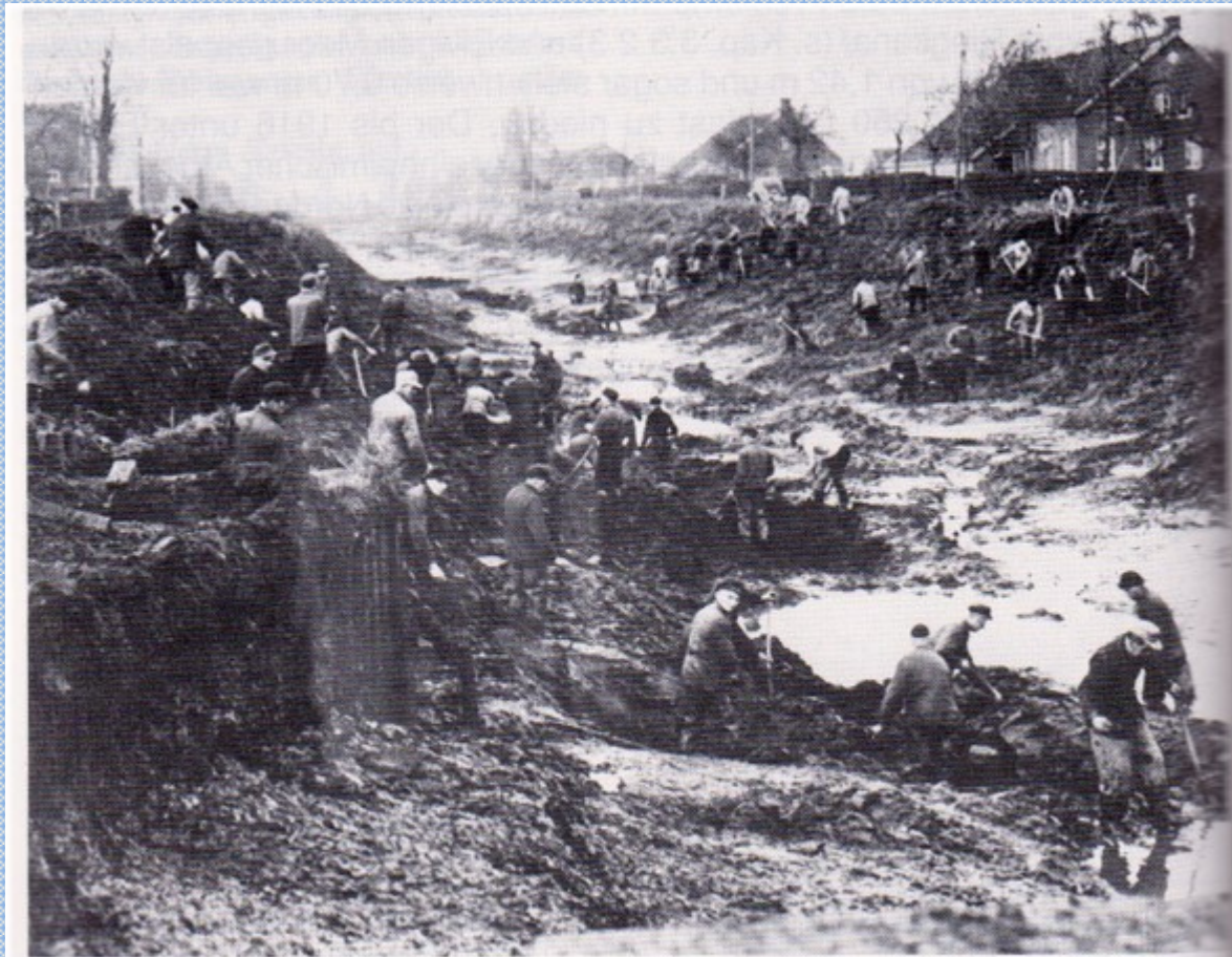
Aufräumarbeiten im Nordgeorgsfehnkanal bei Marcardsmoor (km 42,4)
